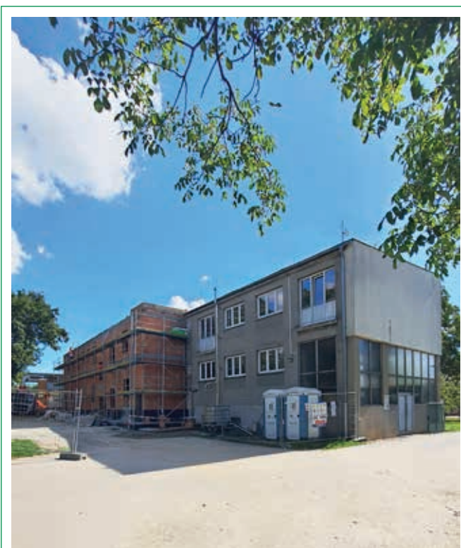
Po celé prázdniny probíhaly stavební práce na rekonstrukci pavilonu A, ve které byla provedena přístavba sociálního zařízení, výtahu a schodiště. Kolaudace stavby je naplánována na listopad.
