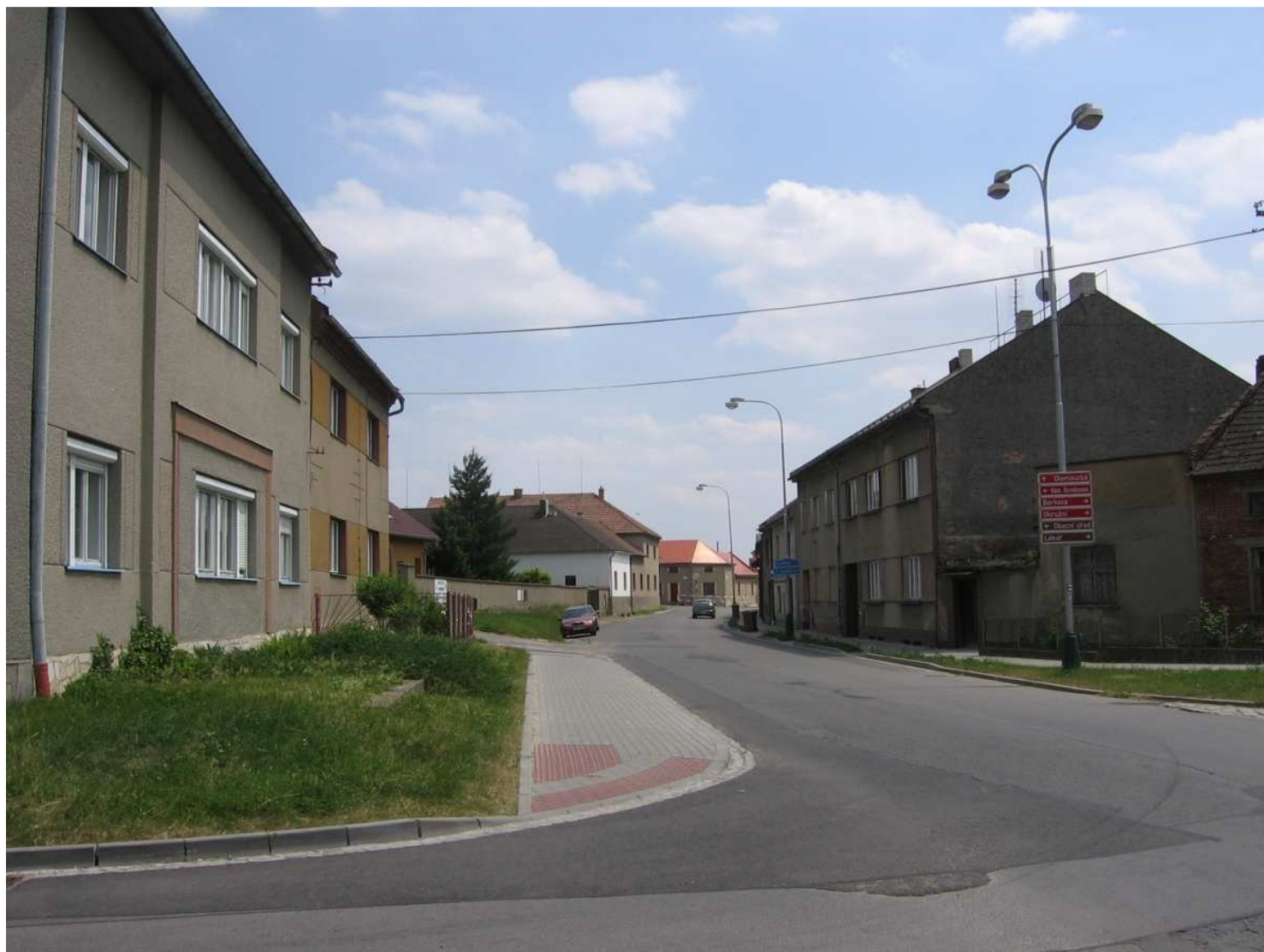
Foto 2 Nový chodník ul. Skrbeňská
