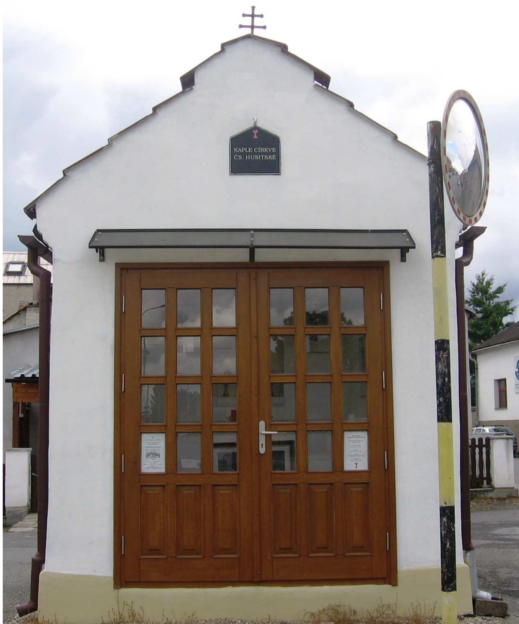
Foto 27 Opravená kaple CČH
